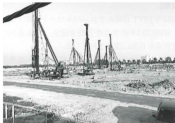
写真-8 ハンマー式杭打機
