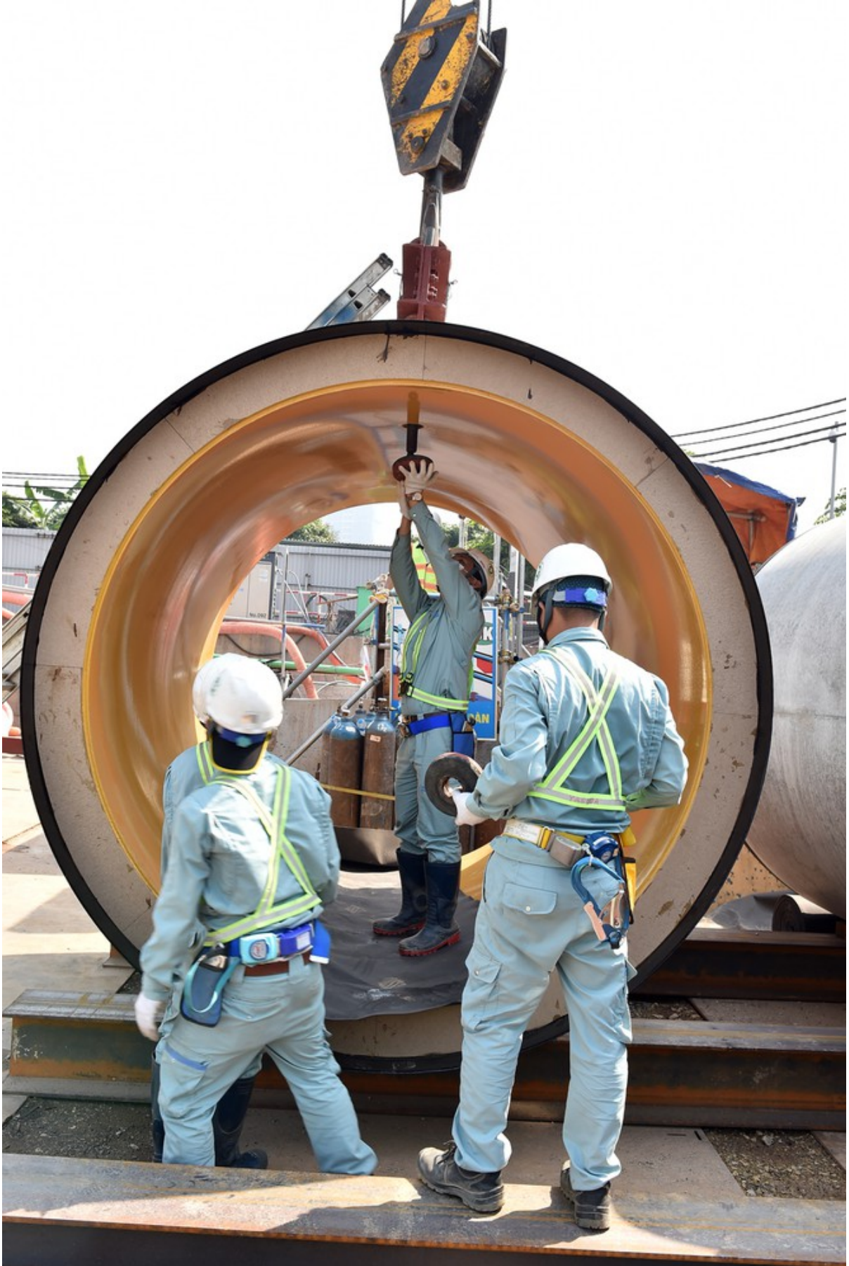
Ngày 28/4, Ban quản lý dự án đầu tư xây dựng công trình cấp nước, thoát nước và môi trường TP Hà Nội (BQLDA) tiến hành đưa công nghệ khoan kích ngầm (Pipe Jacking) vào hoạt động để thu gom nước thải.
