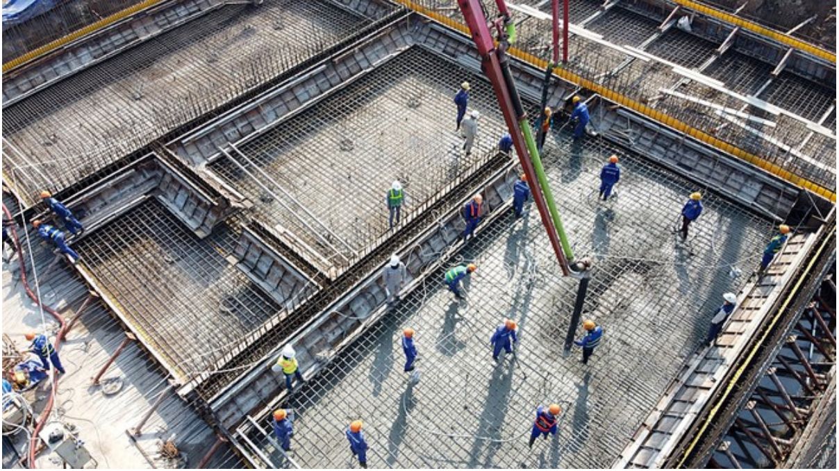
Dự án Hệ thống xử lý nước thải Yên Xá thành phố Hà Nội dự kiến hoàn thành trong năm 2021.
