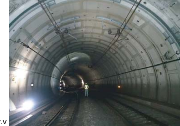
Khảo sát đường hầm
