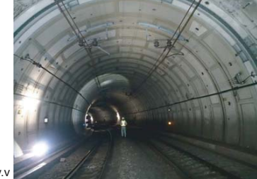
Khảo sát đường hầm
